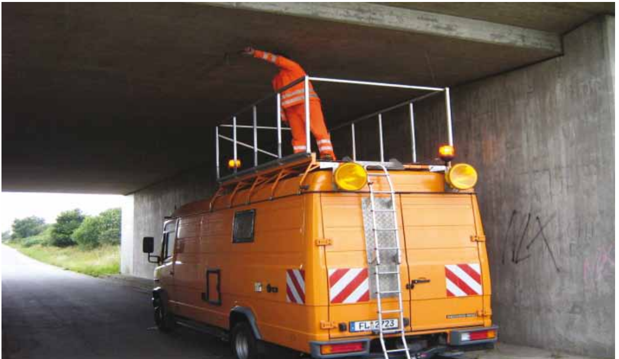
Bild 37: Prüffahrzeug mit begehbarem Dach
