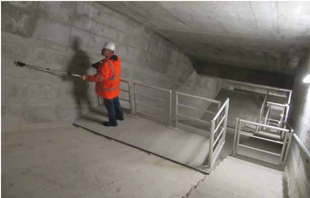
Bild 24: Ausstattung zur Prüfung eines Bogeninnenraumes
