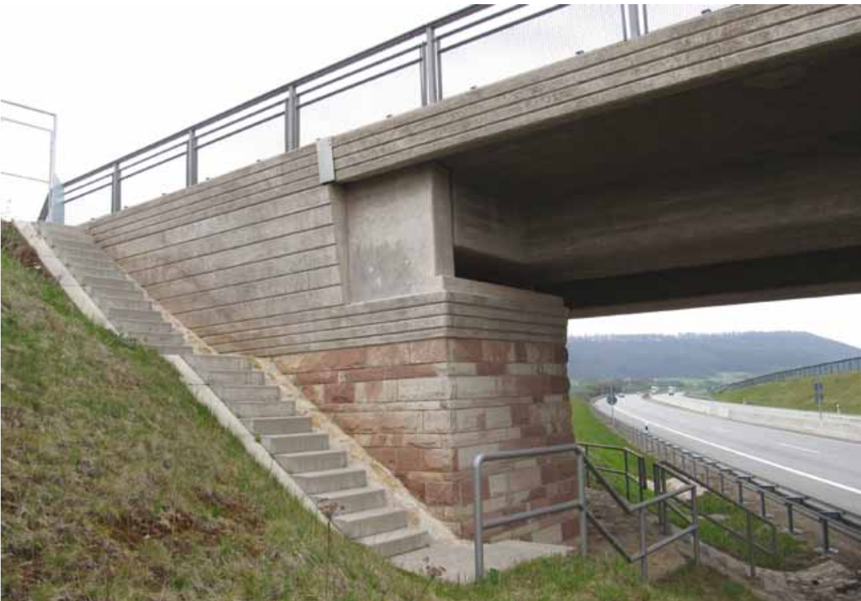
Bild 22: Böschung mit Böschungstreppe und Berme vor Widerlager (gute konstruktive Lösung)
