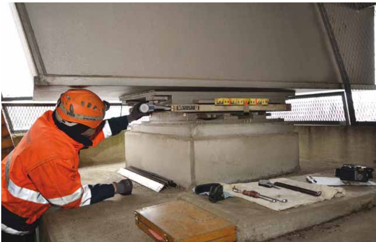
Bild 28: Lagerprüfung (gute konstruktive Lösung)
