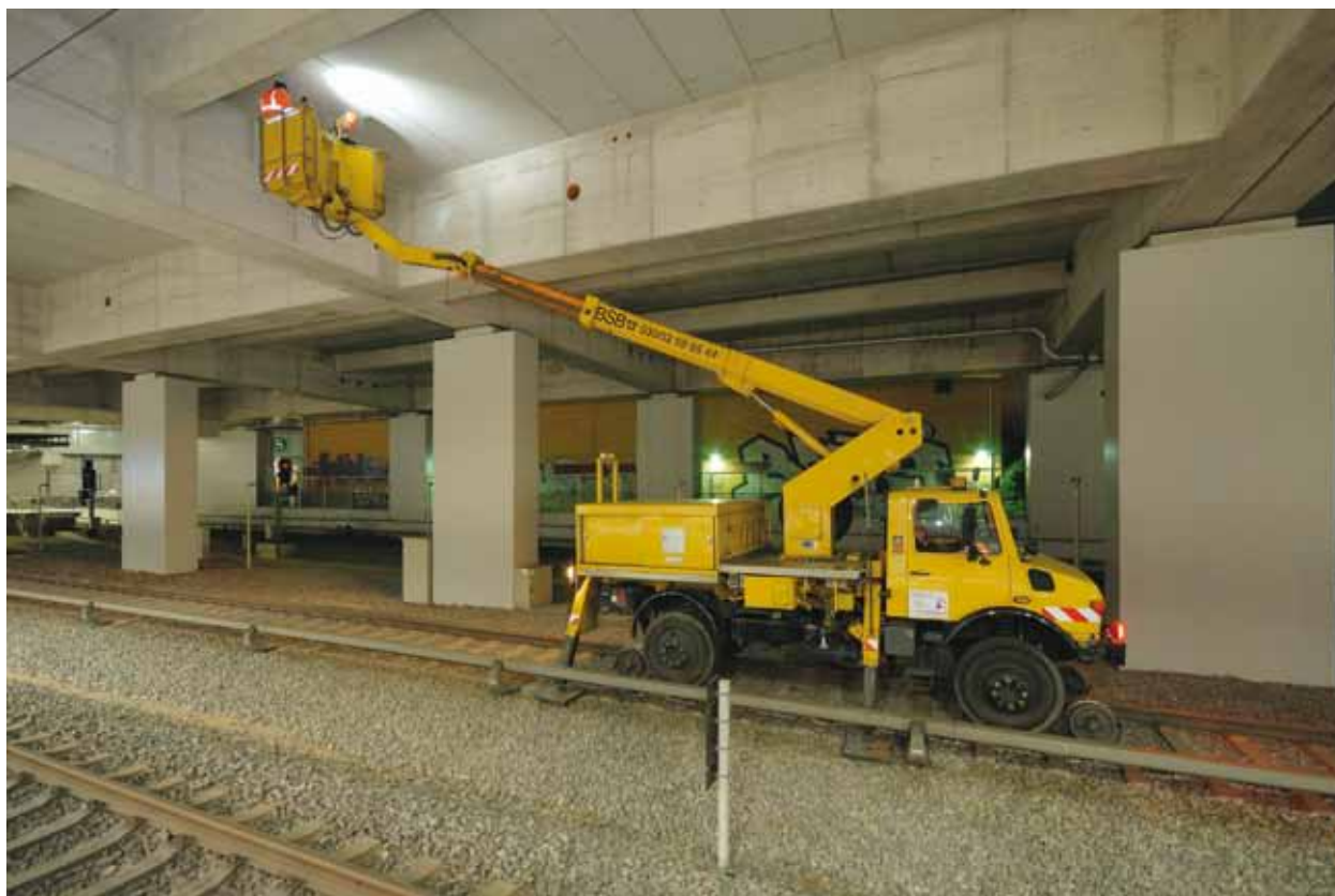
Bild 35: Prüfung im Gleisbereich mit Zweiwegefahrzeug
