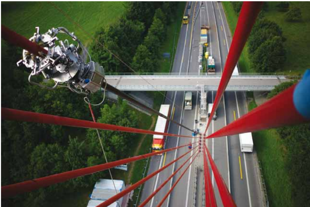
Bild 17: Seilbefahrung mit Korrosionsschutzapplikation
