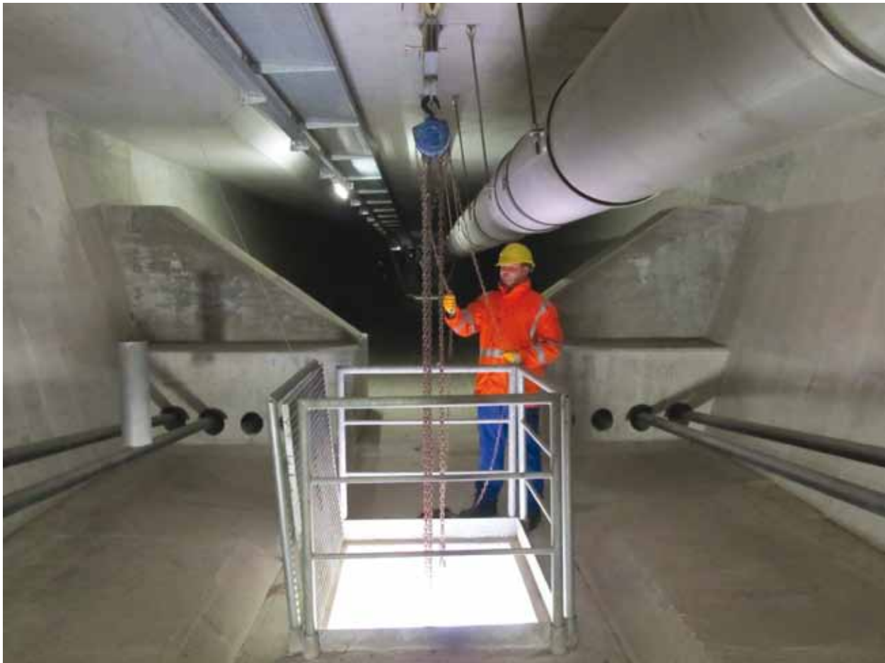
Bild 25: Hohlkastendurchstieg mit Lastaufnahmeeinrichtung
