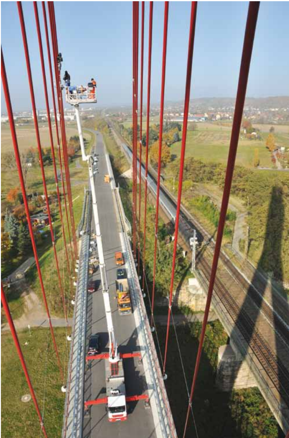
Bild 32: Seilprüfung vom Korbgerät aus (Höhe bis 100 m)
